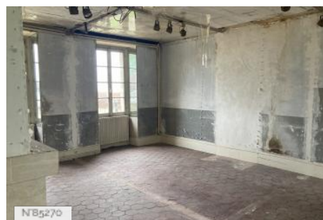
Chateau d'Hazeville - Appartement désaffecté
