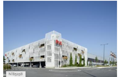
Marché International de Rungis - Parking silo
