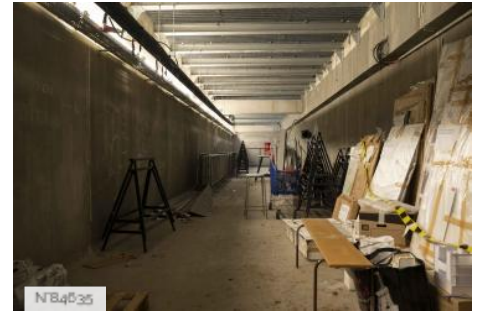
Ecole Nationale Supérieure d'Architecture (ENSA) Paris-Val de Seine - Sous-sol
