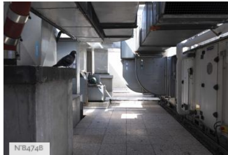
Ecole Nationale Supérieure d'Architecture (ENSA) Paris-Val de Seine - Toit
