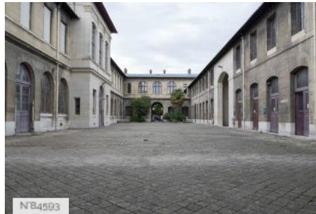
Ecole Nationale Vétérinaire d'Alfort - Cour pavée
