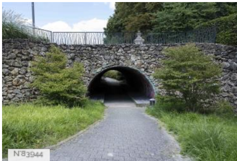
Parc de Noisiel - Tunnel
