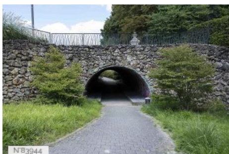
Parc de Noisiel - Tunnel
