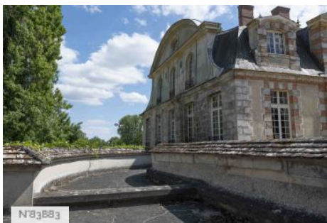
N83883 Château de Nandy - Balcon et façade
