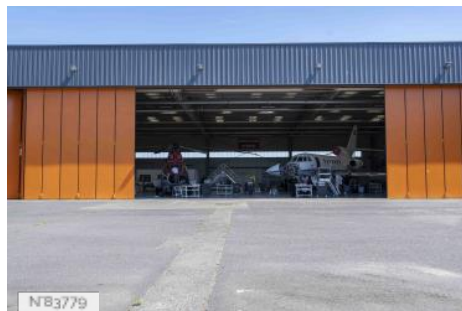
Aéroport de Paris - Le Bourget - Bâtiment AFMAE - Hangar aéroportuaire
