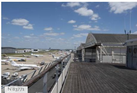
Aéroport de Paris - Le Bourget - Toit terrasse
