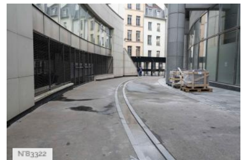
Opéra National de Paris - Opéra Bastille - Quai de déchargement
