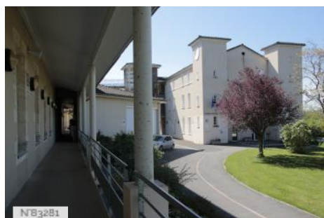
Lycée Beaulieu Lavacant - Site Lavacant - Extérieurs
