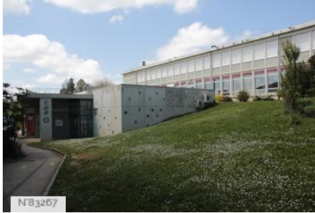
Lycée agricole - Mirande - Extérieurs
