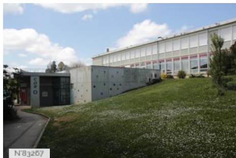
Lycée agricole - Mirande - Extérieurs
