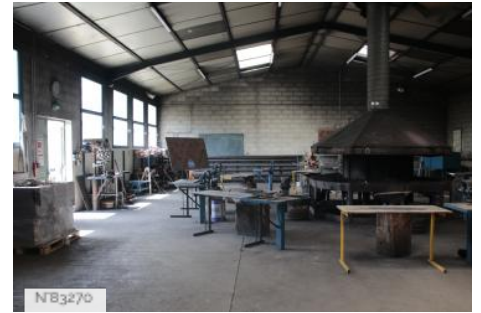
Lycée agricole - Mirande - Ateliers
