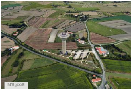
Château d'eau Kulmino
