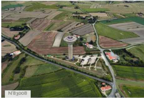
Château d'eau Kulmino
