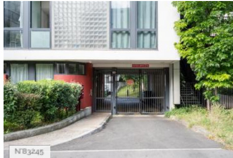
Cité de Refuge - Quai de déchargement
