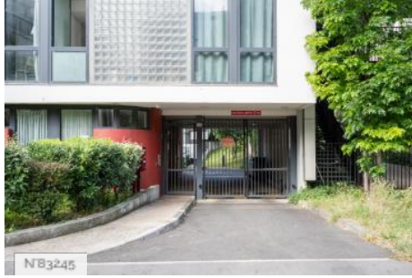
Cité de Refuge - Quai de déchargement
