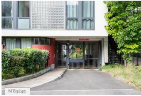
Cité de Refuge - Quai de déchargement
