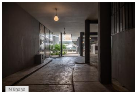
Cité de Refuge - Rue couverte
