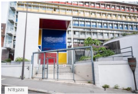
Cité de Refuge - Extérieurs
