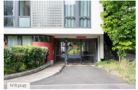
Cité de Refuge - Quai de déchargement
