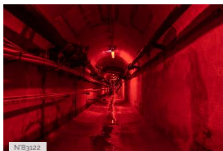
Monnaie de Paris - Tunnel souterrain
