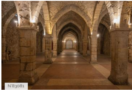
Ville de Provins - Caveau du Saint-Esprit
