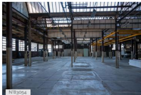
L'orfèvrerie - Anciennes usines - Halle des presses
