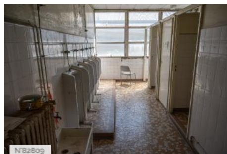
Aérodrome de Melun-Villaroche - Sanitaires désaffectés
