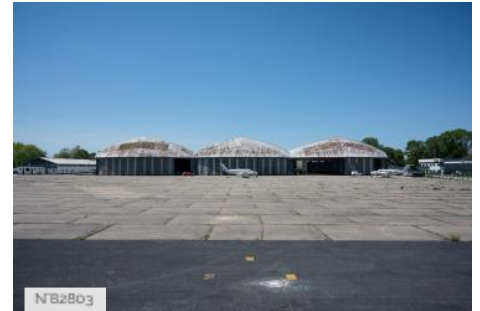
Aérodrome de Melun-Villaroche - Hangars Eiffel - Extérieurs
