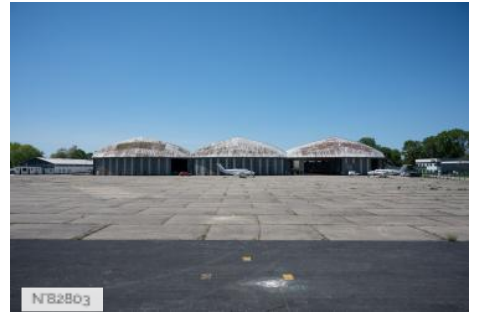
Aérodrome de Melun-Villaroche - Hangars Eiffel - Extérieurs
