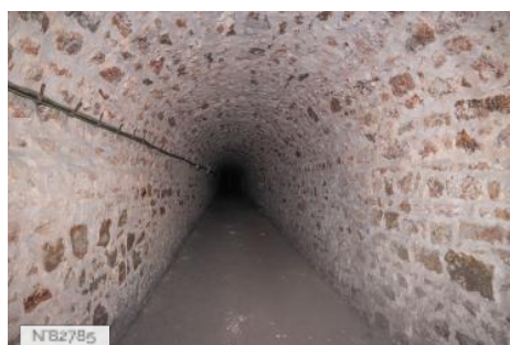
Fort de Saint-Cyr - Couloirs en pierres
