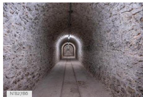
Fort de Saint-Cyr - Tunnel
