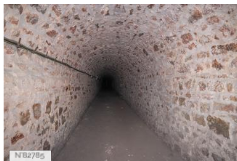
Fort de Saint-Cyr - Couloirs en pierres
