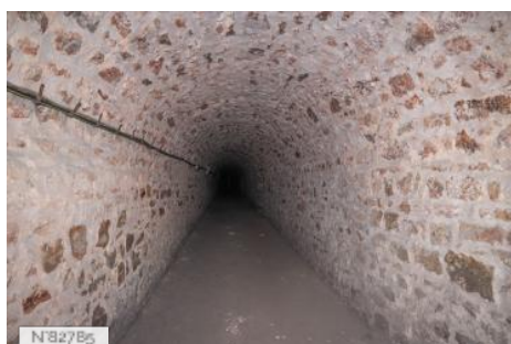
Fort de Saint-Cyr - Couloirs en pierres
