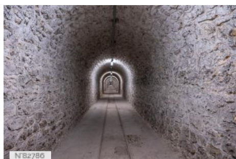
Fort de Saint-Cyr - Tunnel
