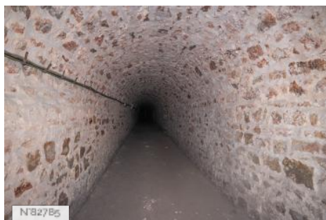
Fort de Saint-Cyr - Couloirs en pierres
