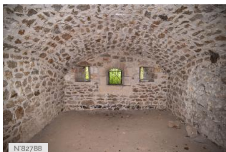
Fort de Saint-Cyr - Chambre de poste de tir
