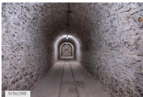
Fort de Saint-Cyr - Tunnel
