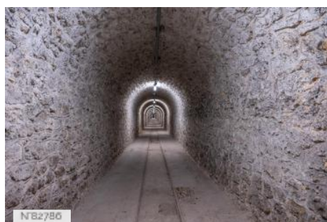
Fort de Saint-Cyr - Tunnel
