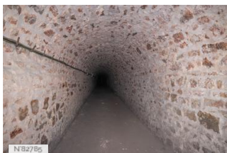
Fort de Saint-Cyr - Couloirs en pierres
