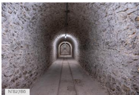
Fort de Saint-Cyr - Tunnel
