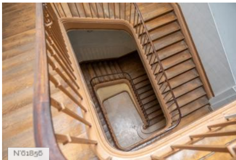
Village éducatif Saint-Philippe - Escaliers
