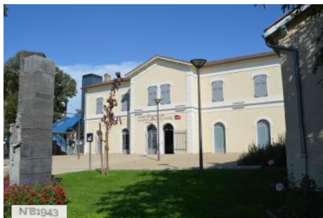
Gare de Sorgues
