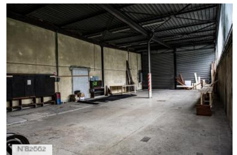
Ancien hippodrome - Entrepôts
