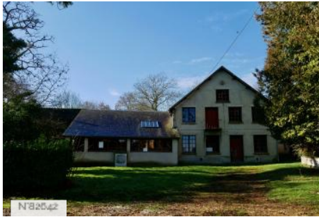
Abbaye Saint-Nicolas - Bâtiment annexe
