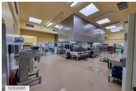
Etablissement Public Départemental de Grugny (EPD) - Cuisines, garage et blanchisserie
