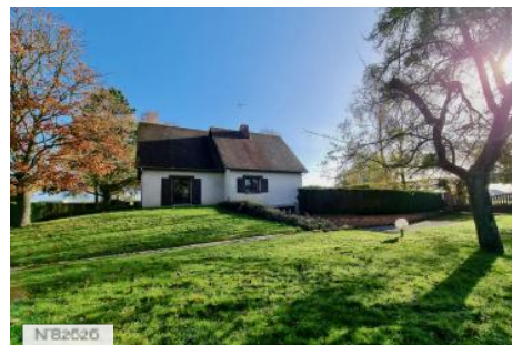
EPD de Grugny - Pavillon
