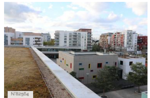
Ville de Cergy - Equipement culturel et social Visages du Monde - Toit terrasse
