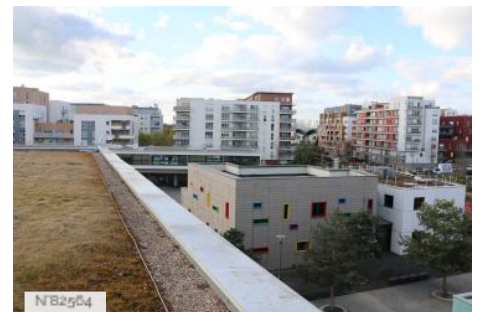
Ville de Cergy - Equipement culturel et social Visages du Monde - Toit terrasse
