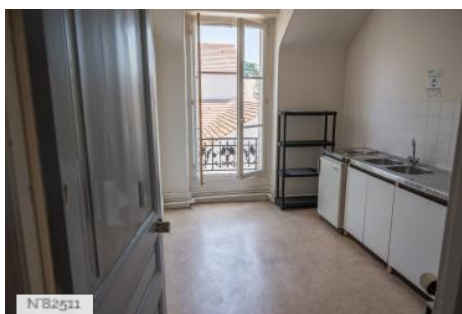
N 82511 Ville de Cergy - Mairie annexe du village - Cuisine
