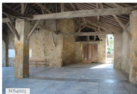
Village de Castelnau Rivière Basse
