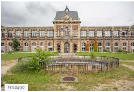
Hôpitaux de Saint-Maurice - Cour d'Honneur du site national
