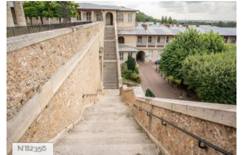
Hôpitaux de Saint-Maurice - Escalier d'Honneur
