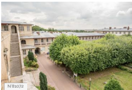
Hôpitaux Paris Est Val-de-Marne (Site Saint-Maurice) - Cour d'Honneur
