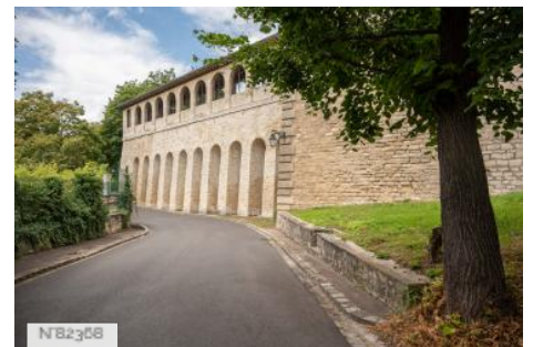
Hôpitaux Paris Est Val-de-Marne (Site Saint-Maurice) - Mur de soutènement
