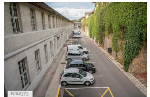
Hôpitaux Paris Est Val-de-Marne (Site Saint-Maurice) - Rue intérieure
