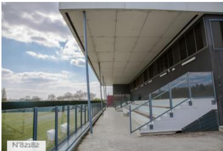
Ville d'Evry-Courcouronnes - Complexe sportif du Lac - Gradins extérieurs
