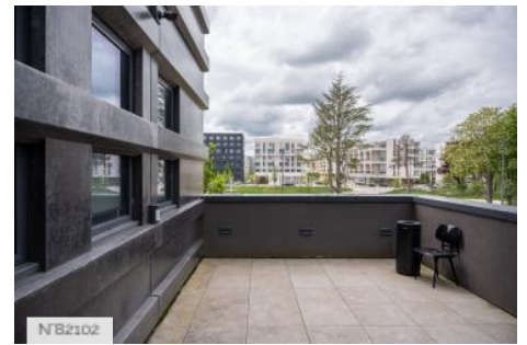
CentraleSupélec - Bâtiment Eiffel - Terrasses extérieures
