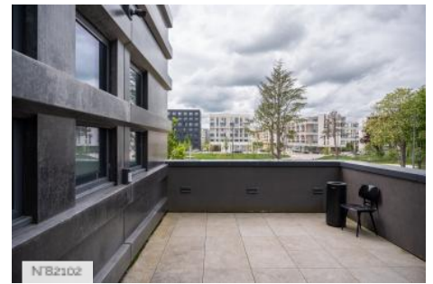
CentraleSupélec - Bâtiment Eiffel - Terrasses extérieures
