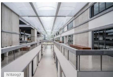
N°82097 CentraleSupélec - Bâtiment Eiffel - Circulation intérieure
